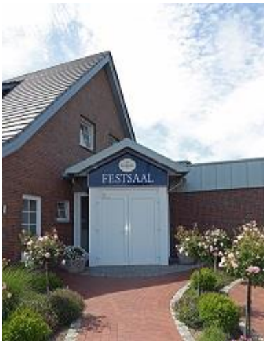
Saaleingang nach Umbau im Jahr 2008
